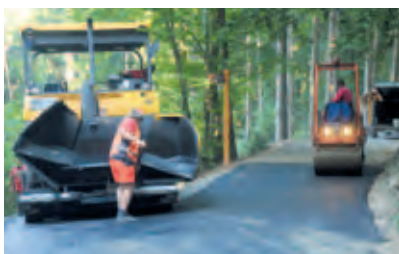
Asfaltování cesty u výběhu makaků /Asphalting the road inside macaques' enclosures/
