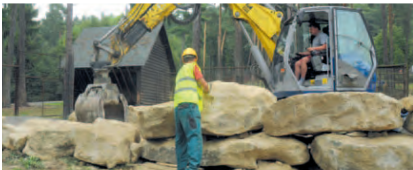
Stavba hrazení ve výbězích safari /Construction of the boards in the safari enclosures/
