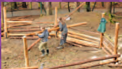
Výstavba oplocenky ve výběhu kozorožců /Construction of enclosures in the Siberian Ibx enclosure/
